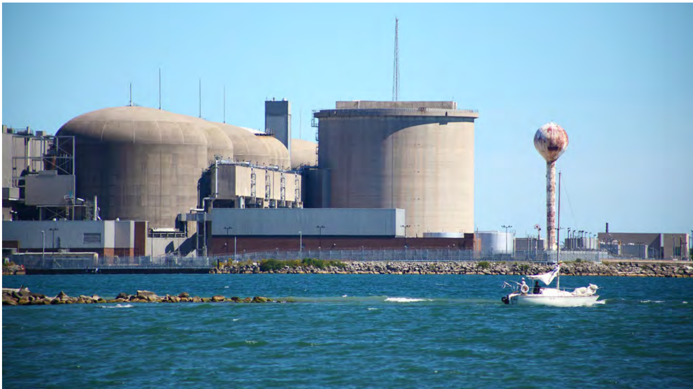
Centrale nucléaire de Pickering en Ontario.
